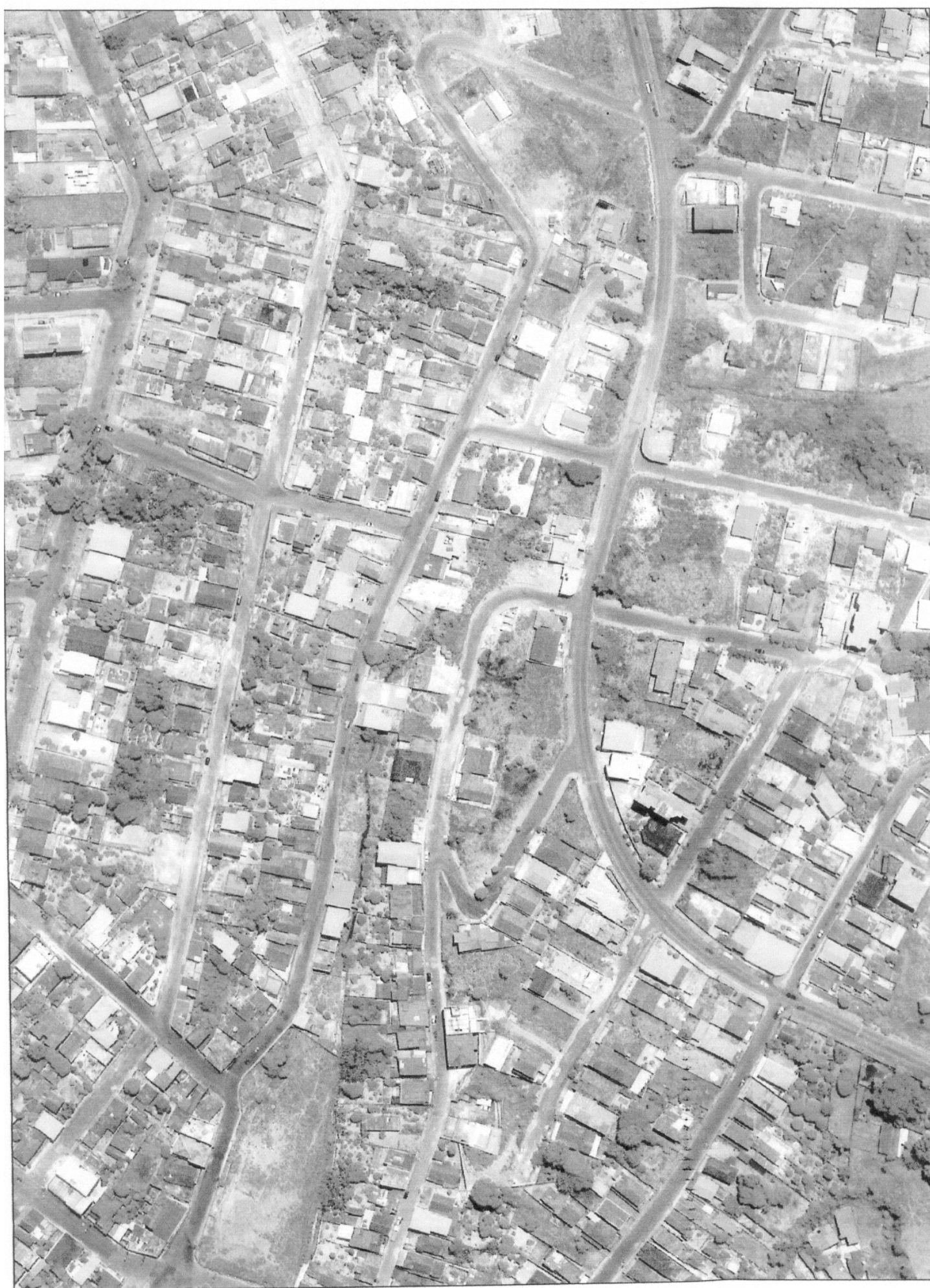
➡ RUA CORONEL ALVES, BAIRRO BELA VISTA
